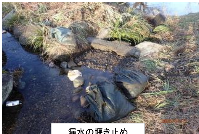
漏水の堰き止め
